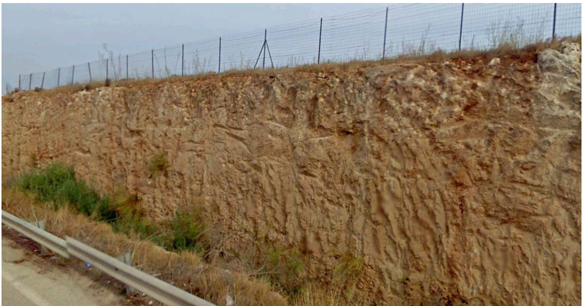
Figura 3-9 - Deposito di un terrazzo marino tardo-quadernario costituito da calcareniti organogene grossolane giallo rossastre, affiorante lungo una trincea della SP n°89, 1,5 km a nord-ovest di Donnalucata.
