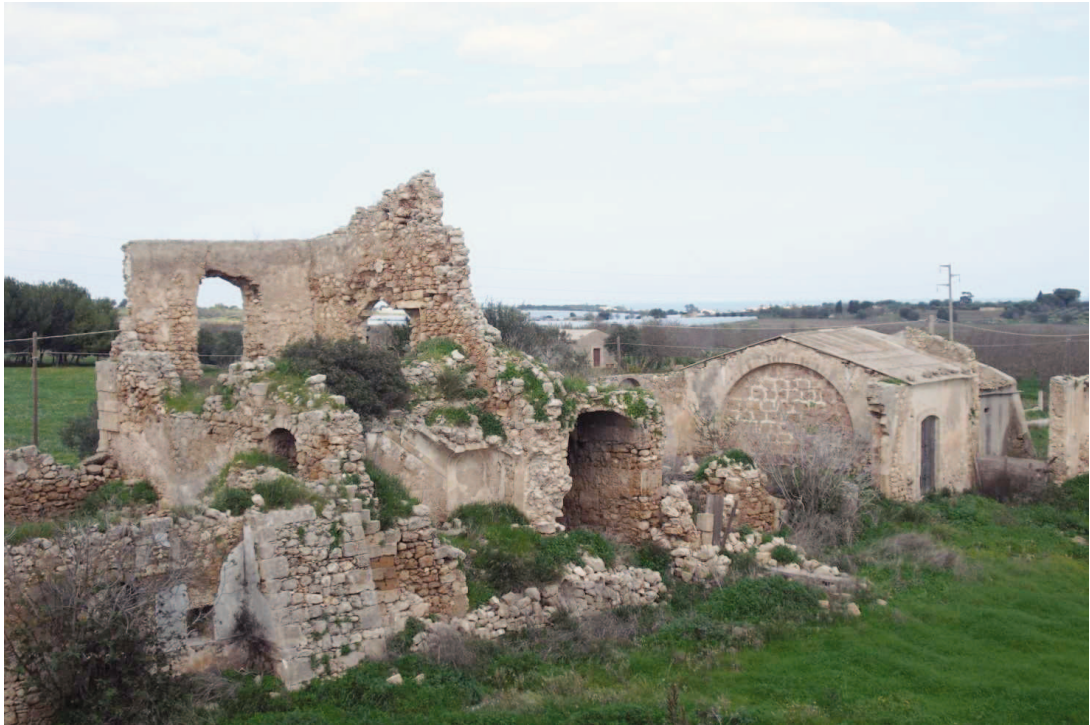
Fig. 9 – Costruzione settecentesca sovrastante la cella Tricora e parte della corte, stato attuale.
