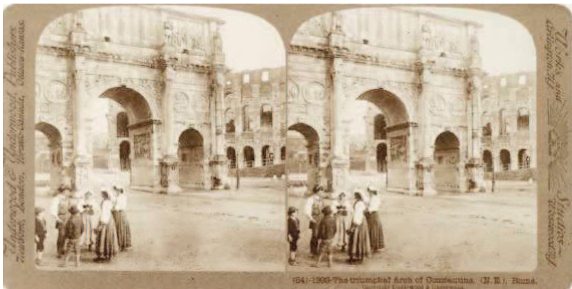
Fig. 35 - Lato meridionale dell'Arco di Costantino - veduta stereoscopica.
