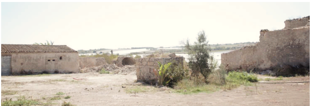
Fig. 10 – Pozzo all'interno della corte.
