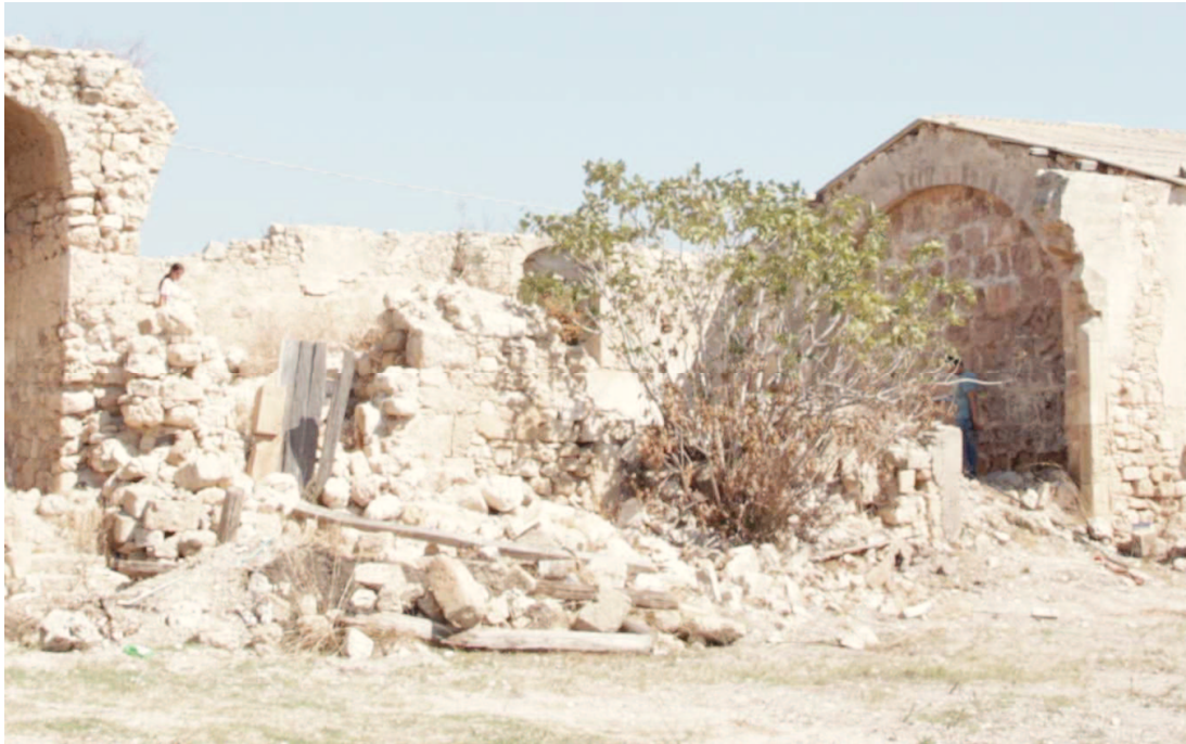
Fig. 23 – San Lorenzo Vecchio. Lato Sud della cella del tempio greco – vista dal cortile.
