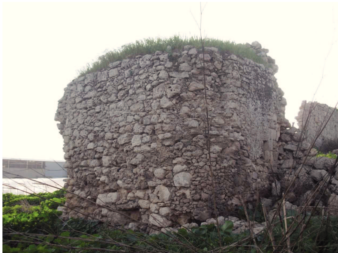
Fig. 20 – Torre angolo sud-est. In alto: interno; In basso: esterno.
