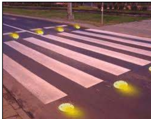
Fig. 32 - Sistemi di sicurezza in corrispondenza degli attraversamenti pedonali
