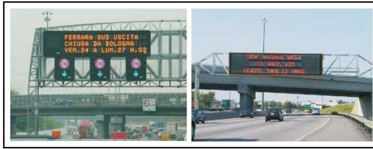
Fig. 20 - Sistemi di informazione in viaggio: pannelli a messaggio variabile
