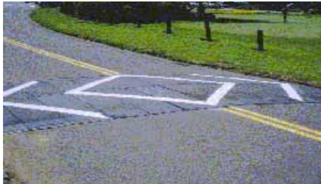
Figura 7.17. Esempio di dosso posto in opera
