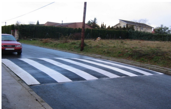
Figura 7.18. Esempio di Attraversamento rialzato posto in opera
