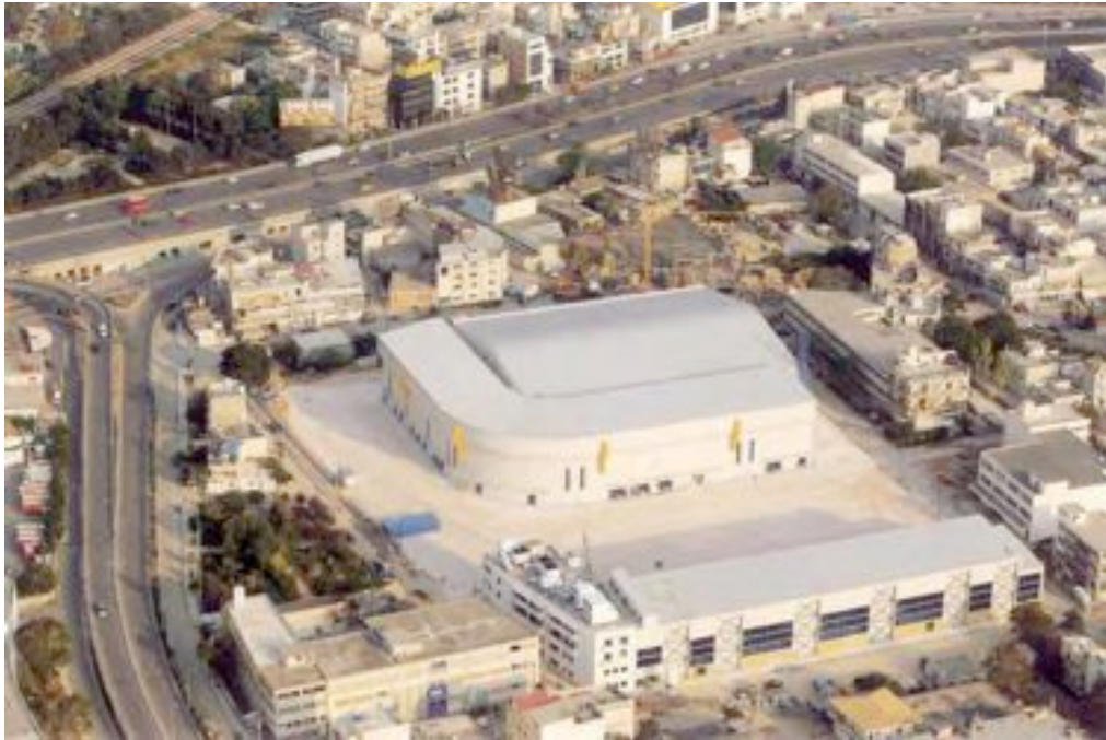
2004, Atene - Impianti olimpici per le gare di pugilato nel comune di Peristeri
