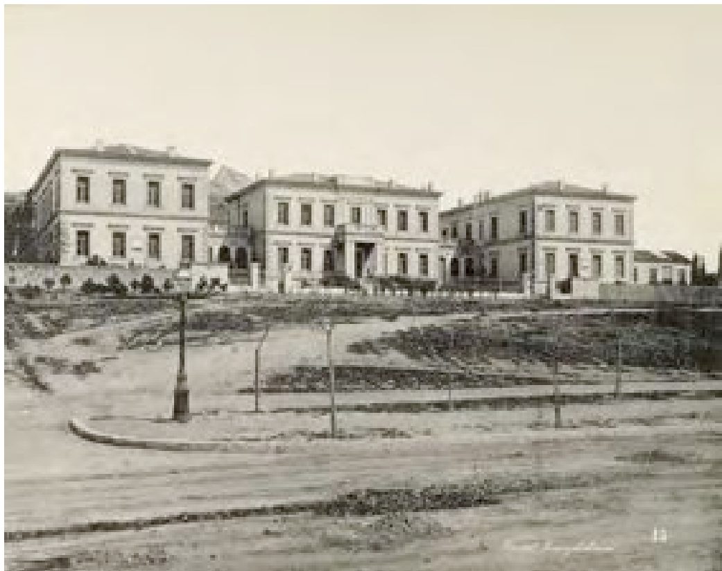
1881-1884, Atene - Costruzione dell'ospedale Evangelismòs
