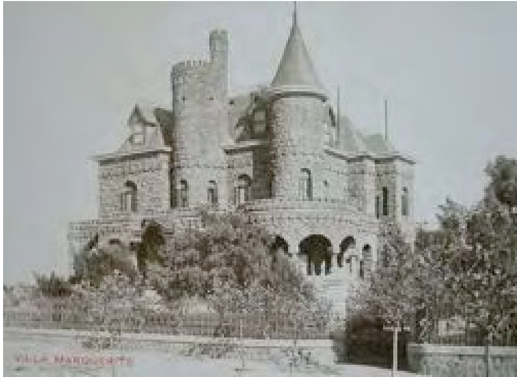
Inizi di XX sec., Atene - "Villa Margherita", angolo Viale Vasilisis Sofias e Mesoghion (fu demolita nel 1970)
