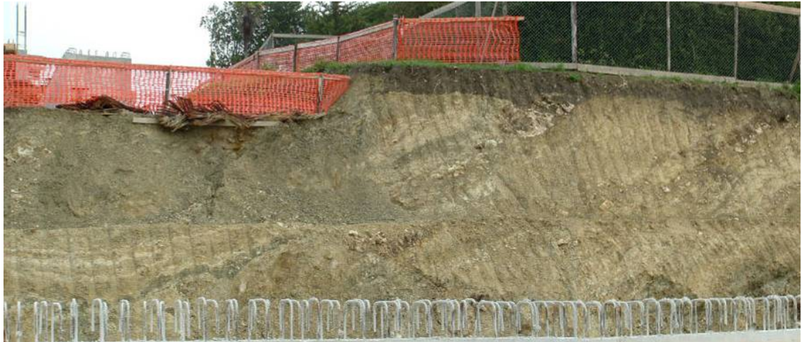
Figura 4.9 – Affioramento del flysch di Faeto nella zona Sud del centro abitato (foto eseguita durante i lavori di ricostruzione).
