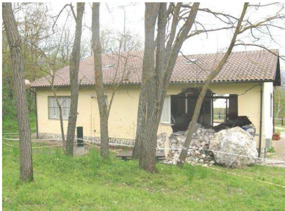
Figura 5.4 – Blocco lapideo distaccatosi dal costone roccioso, arrestatosi dopo l'impatto con un'abitazione.
