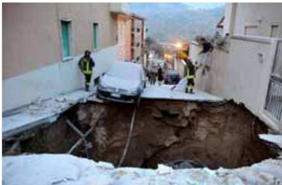
Figura 5.5 – Una voragine venutasi a creare in una strada.
