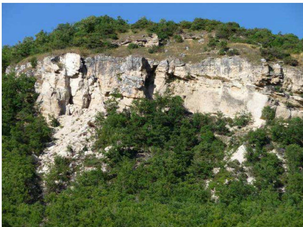
Figura 5.3 – Vista di un costone interessato da fenomeni di caduta massi.
