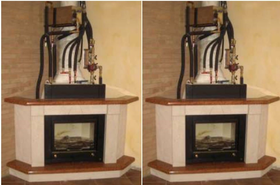
Figura 102: Esempio di termo camino
