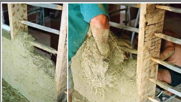
MESSA IN OPERA DEL TORCHIS
