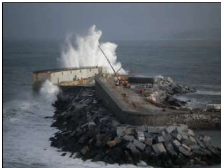
Figura 3.2: Foto della diga di Mutriku (Spagna) con all'interno il dispositivo OWC (Torre Enciso et al., 2009).
