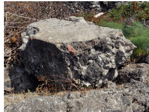
Fig. 84. Paramenti murari superstiti e macerie del campanile.
