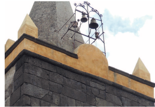
Fig. 68. Il coronamento e il castelletto campanario esterno.
