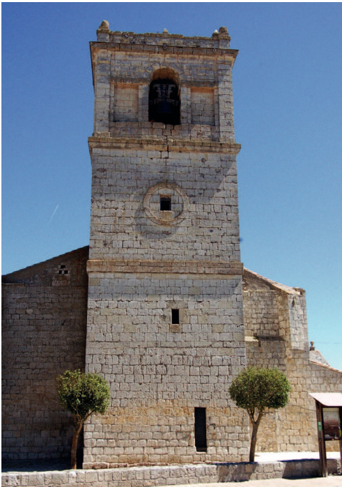
Fig. 129. Vista del prospetto settentrionale della torre.
