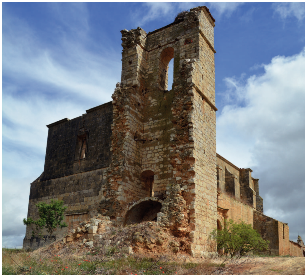
Fig. 150. A, destra, il rudere della chiesa e della torre campanaria. Vista prospettica.
