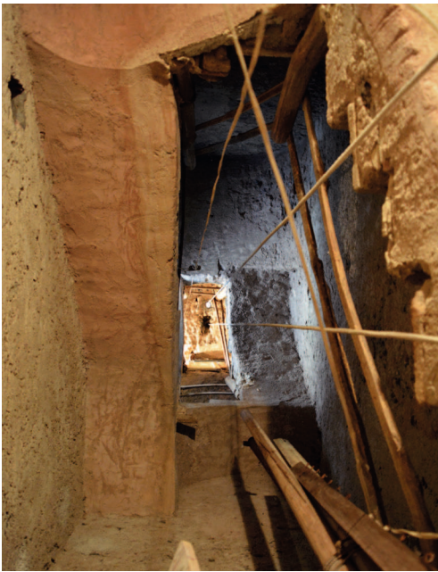
Fig. 34. La scala a pozzo su volte rampanti. Vista iposcopica.
