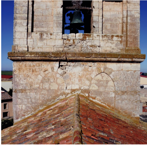
Fig. 135. Archivolti ogivali murati in corrispondenza della camera occulta.
