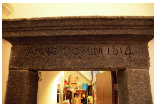
Fig. 62. Ingresso al campanile. Architrave in pietra lavica che riporta la data di costruzione della torre (1614).
