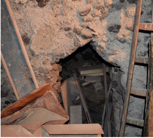
Fig. 33. Arco alla cappuccina in apertura murata dalla giustapposizione della scarpa al fusto.
