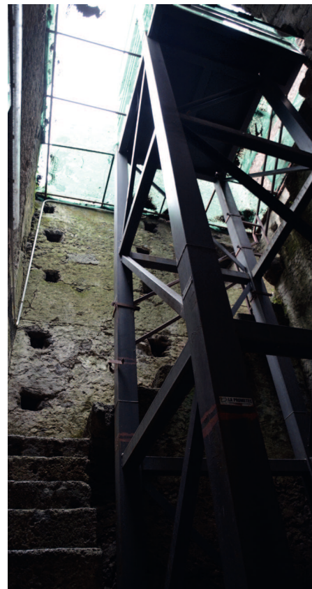
Fig. 83. Vista interna del rudere della torre campanaria.
