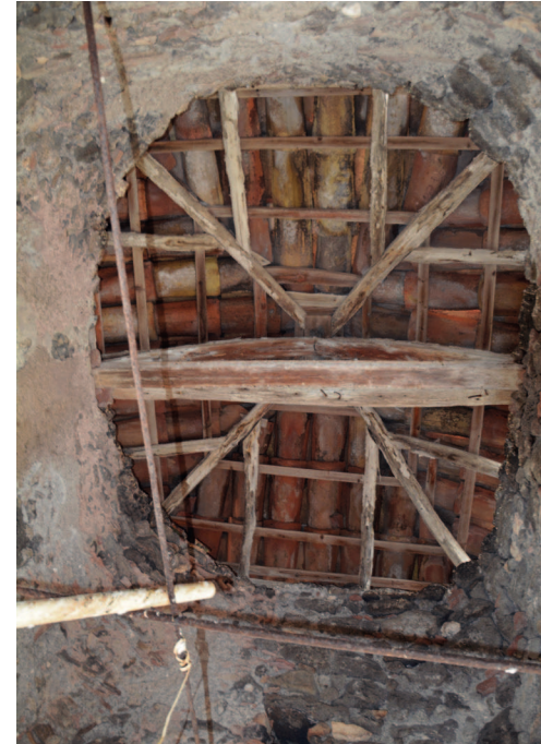
Fig. 39. Pennacchi "sferici" e il sistema di copertura della cella campanaria attuale. Vista iposcopica.
