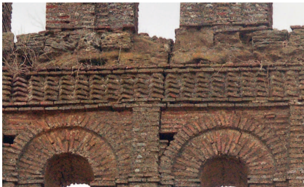
Fig. 146. In alto a sinistra, la scala a chiocciola; in alto a destra la volta e le sezioni murarie. A lato, dettaglio del fregio con “esquinillas” tra penultimo e ultimo ordine.
