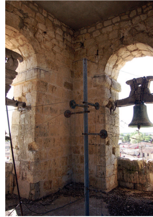
Fig. 134. A sinistra, il solaio che sormonta il primo livello. a destra, la cella campanaria e gli archivolti delle monofore.
