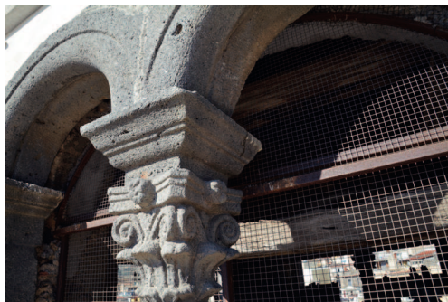
Fig. 112. Particolare della bifora in pietra lavica in Santa Maria della Catena a Bronte.
