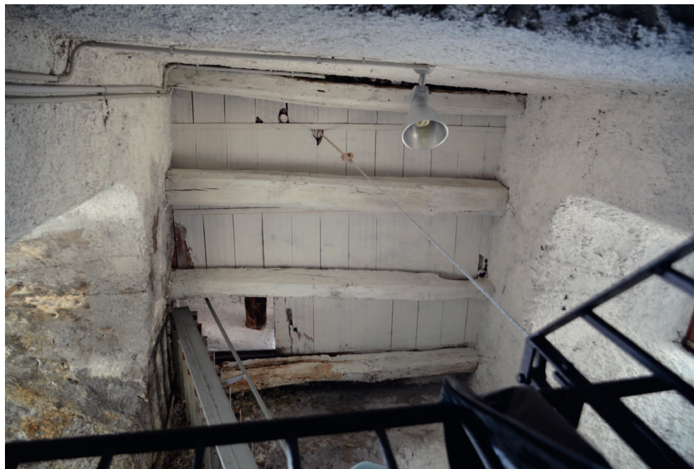
Fig. 66. Solaio in putrelle e tavelloni a conclusione superiore del primo livello.
