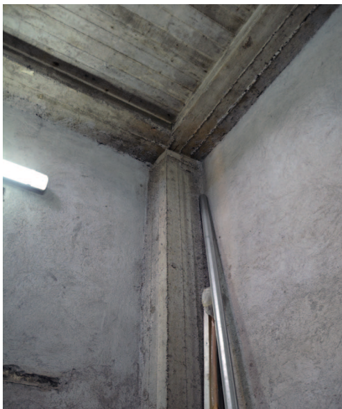
Fig. 114. Scheletro portante in c.a. nella torre della SS. Trinità.
