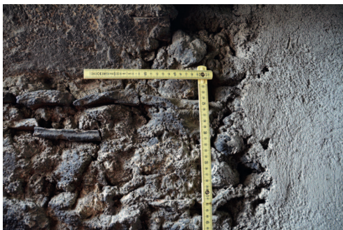
Fig. 100. Muratura in blocchi di basalto informi, ciottoli di fiume e ripianamenti in frammenti di laterizio nella SS. Trinità a Bronte.
