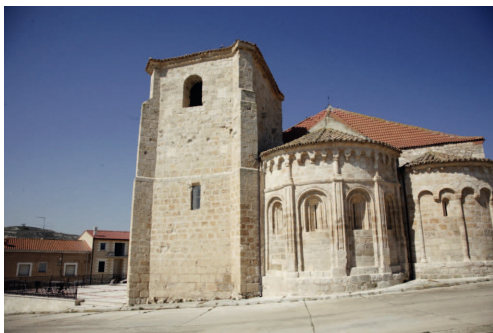
Fig. 120. Torre a pianta quadrata con contrafforti angolari, chiesa parrocchiale di Villaconancio (Palencia).
