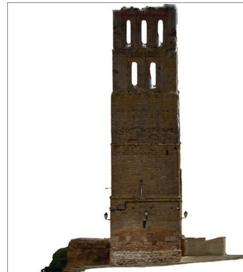
Fig. 1. In alto, modello mesh tratto da nuvola di punti SfM del campanile di San Giuseppe ad Acicastello. In basso, ortofoto tratta dal modello di stessa tipologia nella torre di San Pedro a Villacarralon.
