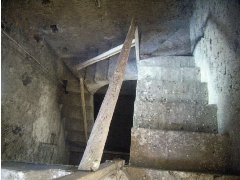
Fig. 91. Scale a pozzo nella torre campanaria di Santa Maria dell'Aiuto a Catania (Fonte: Carta del Rischio).
