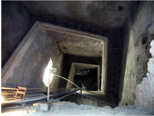
Fig. 107. Scala a pozzo su volte rampanti. Pedara, Santa Caterina (Fonte: Carta del Rischio).
