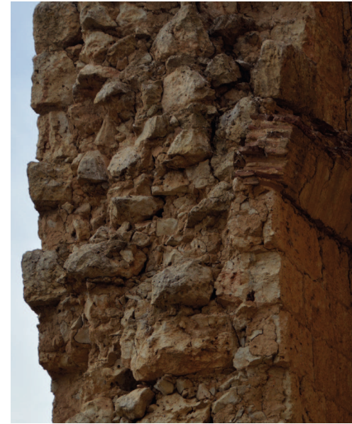
Fig. 162. Dettaglio della sezione muraria del paramento superstite.
