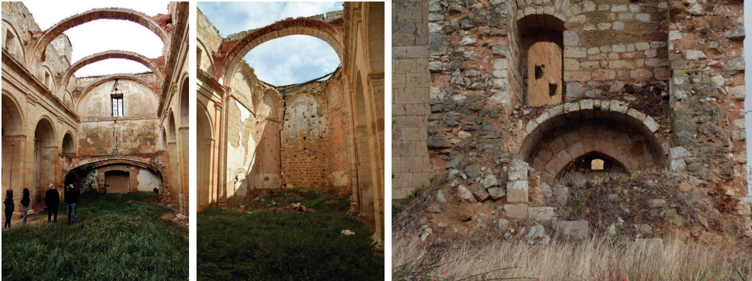
Fig. 151. Viste interne del rudere della chiesa e della torre campanaria.
