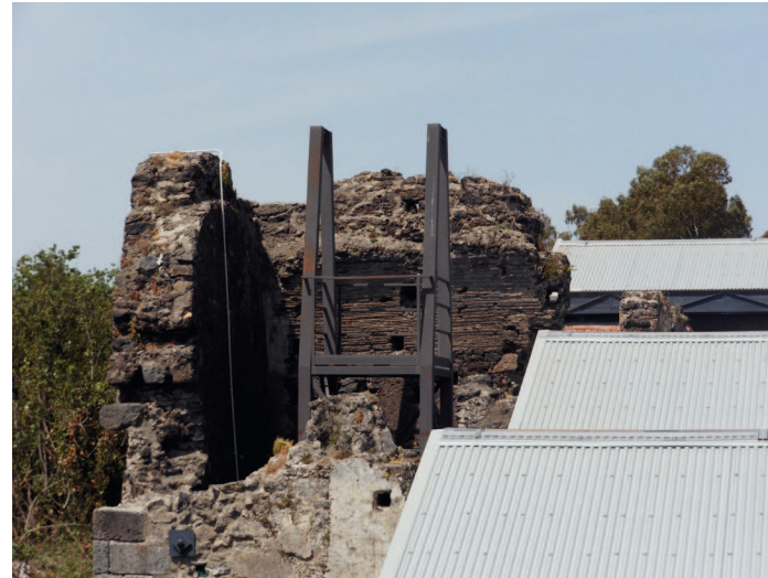
Fig. 87. Sopra: Viste della parte alta superstite della torre campanaria. Sotto: aramento interno della torre campanaria. In primo piano i ripianamenti della muratura. Frammenti lapidei della cuspide.
