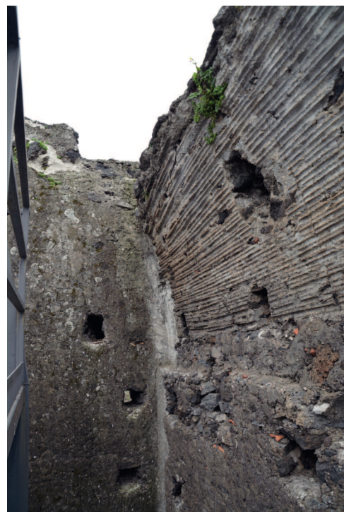
Fig. 86. Parte superstite della volta a botte a concrezione con la traccia della stuoia di canne.
