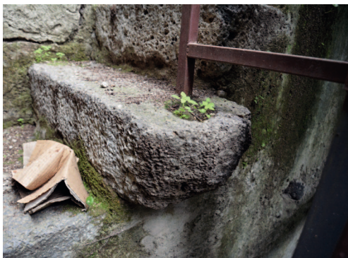
Fig. 85. Gradini in pietra lavica della scala.
