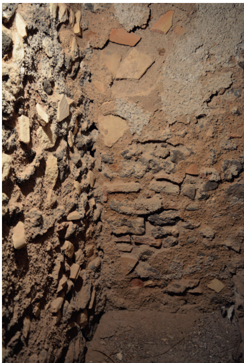
Fig. 38. Rincocciata in frammenti di laterizio nei paramenti interni del fusto.
