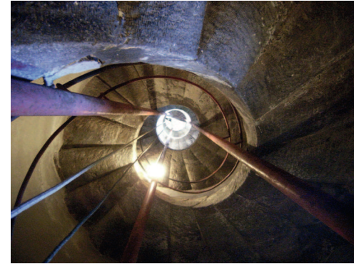
Fig. 109. Scala a chiocciola “ caracol de Mallorca ”. Catania, SS. Sacramento al Borgo (Fonte: Carta del Rischio).
