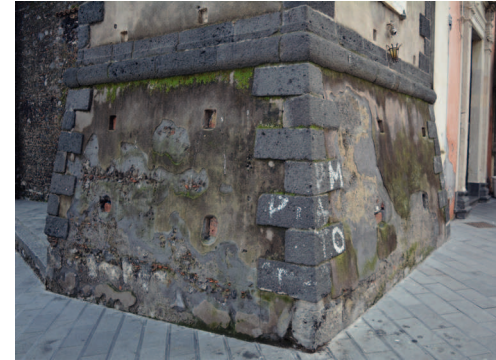
Fig. 31. Il basamento a scarpa con cantonali.
