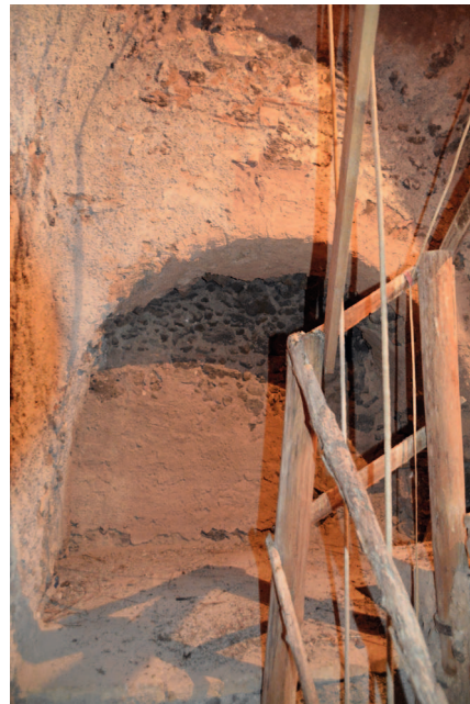
Fig. 35. Archivolto su cui poggia il paramento sud della cella campanaria.
