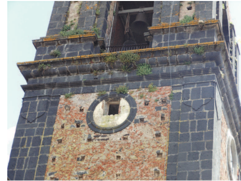
Fig. 96. Cantonali e trabeazione ai piedi della cella campanaria di San Nicolò a Randazzo.
