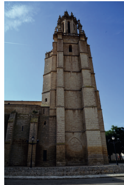
Fig. 119. Torre a pianta quadrata con contrafforti, Colegiata de Ampudia (Palencia).
