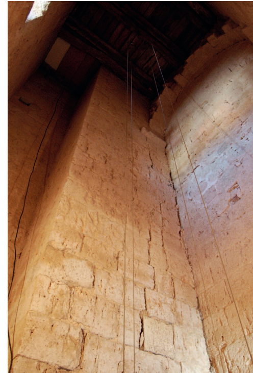
Fig. 131. Scorcio dell'interno della torre. Primo livello.
