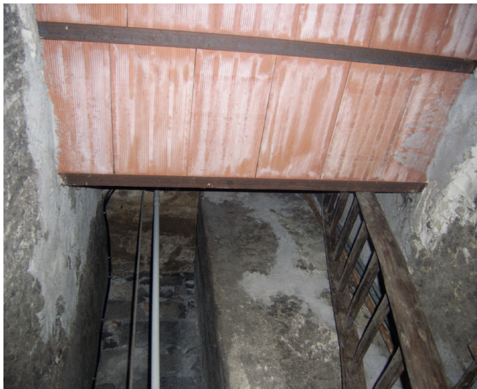
Solai in profilati NP e tavelloni
