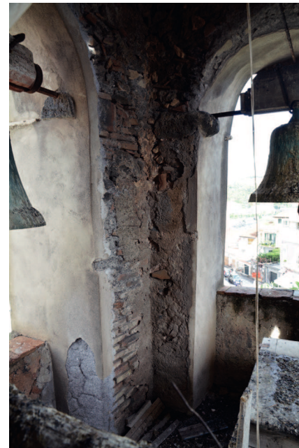
Fig. 36. Piedritti della cella campanaria.
