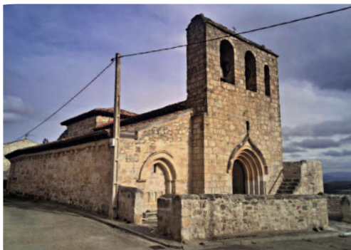
Fig. 122. Torre espadaña, San Miguel en Aza (Burgos).
