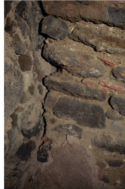
Fig. 37. dettaglio della ghiara di pignaletti in basalto bolloso dell'archivolto che sostiene parte della cella campanaria.
