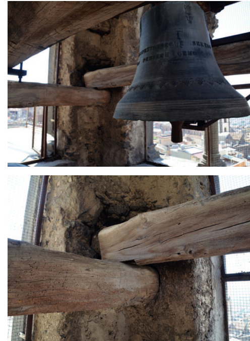
Fig. 113. Bronte, travi lignee di supporto della campana centrale in Santa Maria della Catena a Bronte.
