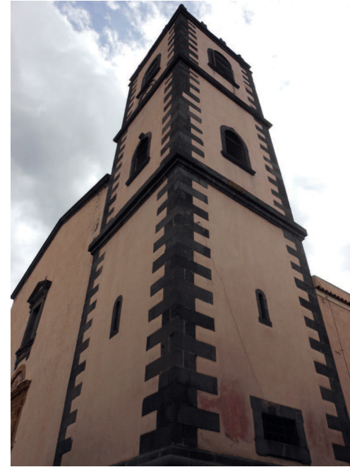
Fig. 111. Torre campanaria di Santa Maria dell'Annunziata a Bronte.
