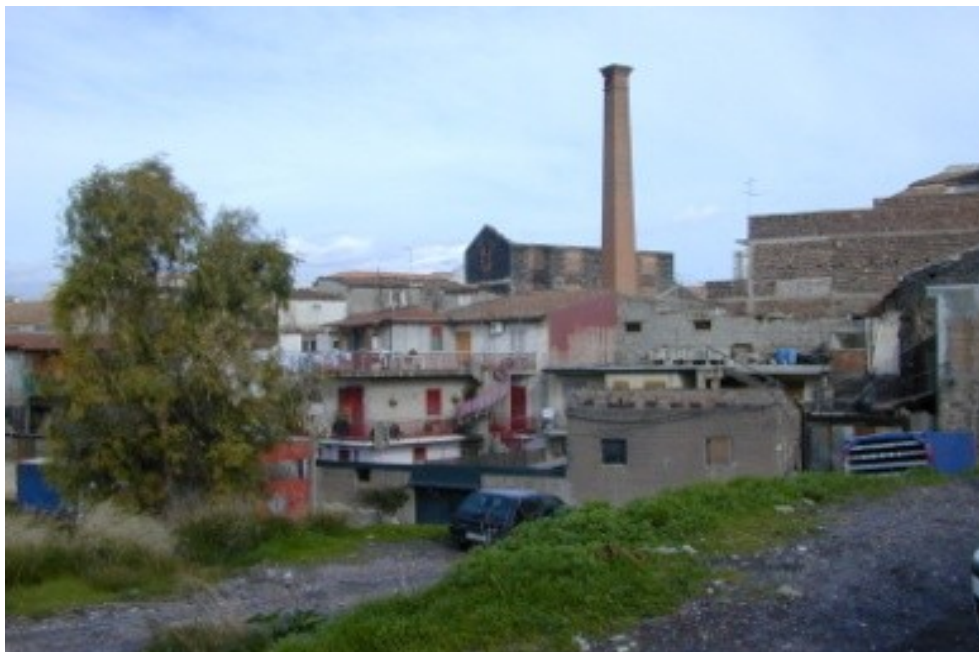
Fig. 5.15 – Edilizia residenziale nel rione di S. Cristoforo Sud
