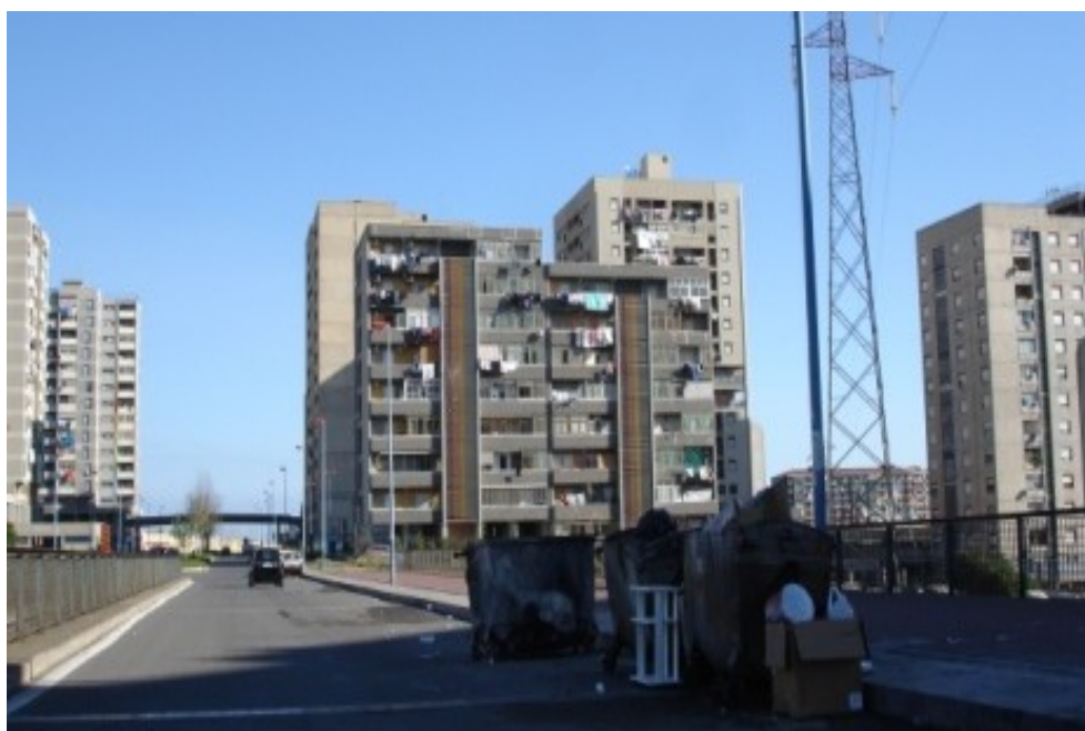
Fig. 5.11 – Edifici residenziali in viale S. Teodoro (Librino)
