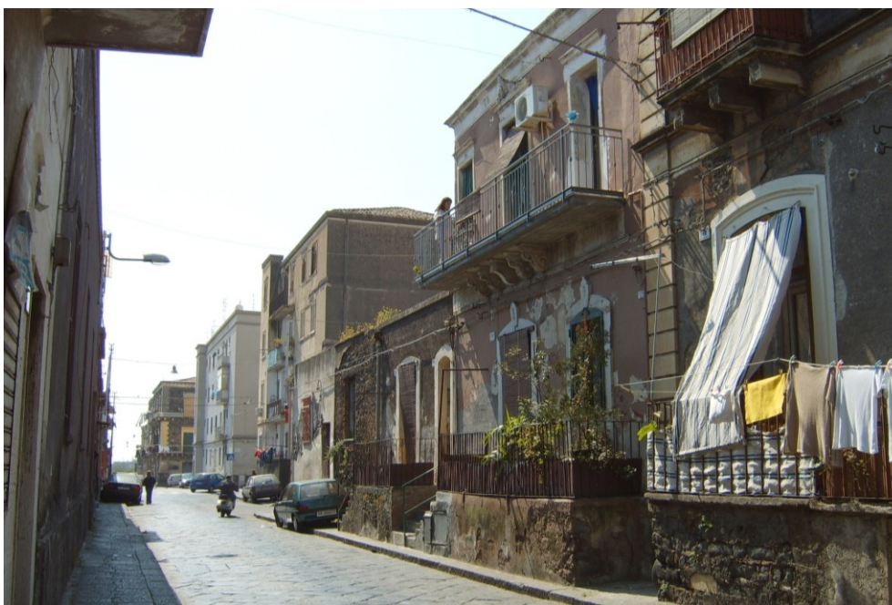
Fig. 5.16 – Aree degradate a S. Cristoforo Sud
