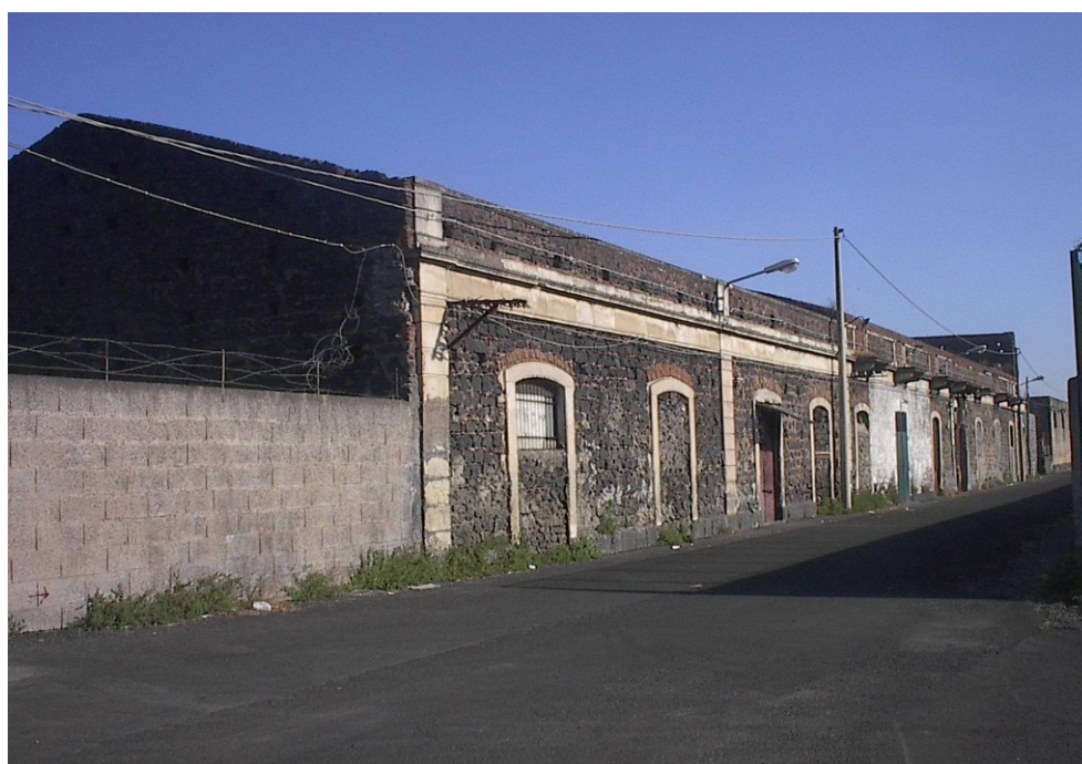
Fig. 5.18 – Edilizia storica da recuperare in via Belfiore ( S. Cristoforo Sud )
