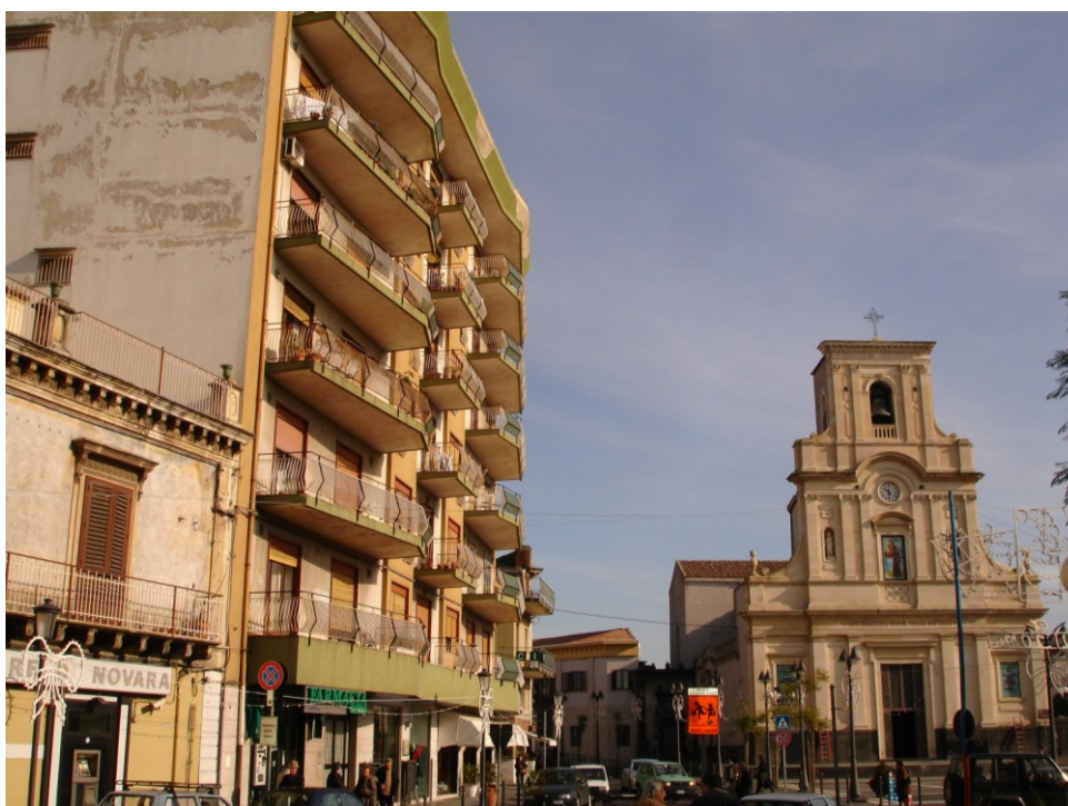
Fig. 3.12 – Nuove costruzioni nei centri storici dei comuni etnei
