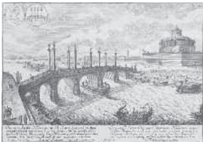
90/ Veduta ricostruttiva del mausoleo di Adriano dall'Entwurf einer historischen Architektur (1721) di Fischer von Erlach
