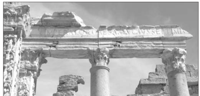
223. Basilica severiana. Particolare del colonnato con tarbeazione.
