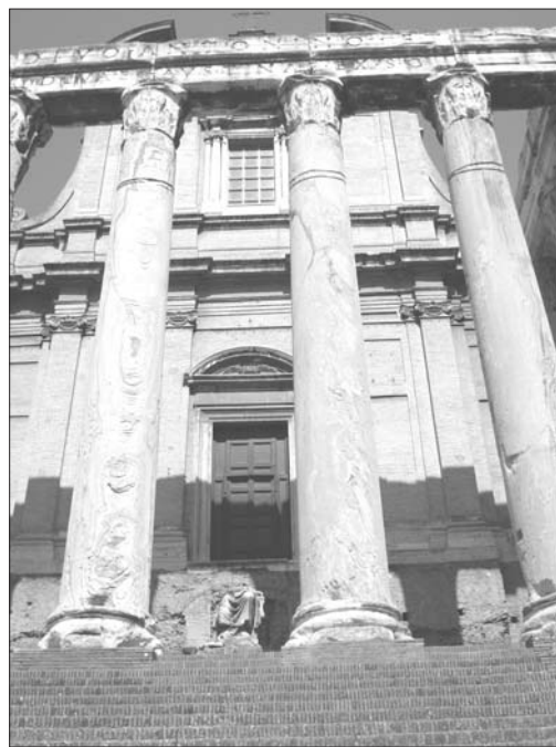
106. Tracce di solchi per le corde da demolizione.
