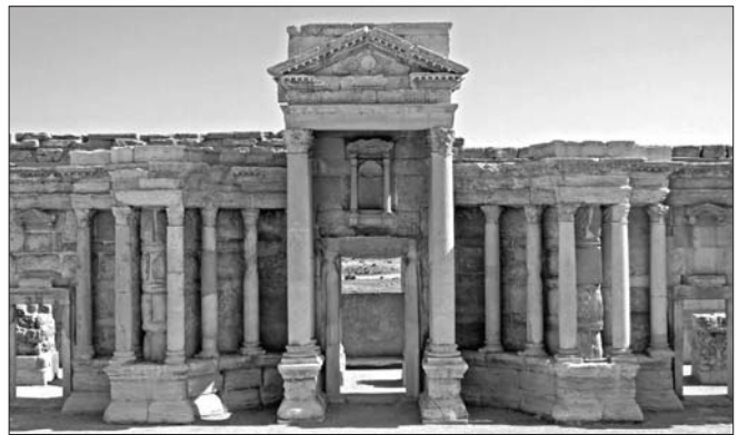
388. Palmira. La parete, postscenium, del teatro romano
