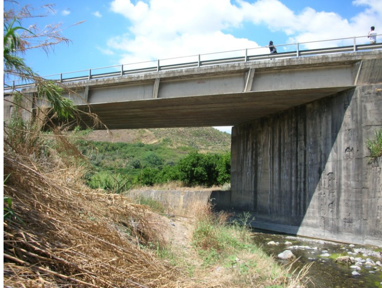
Figura 26 Ponte al km 31+720
