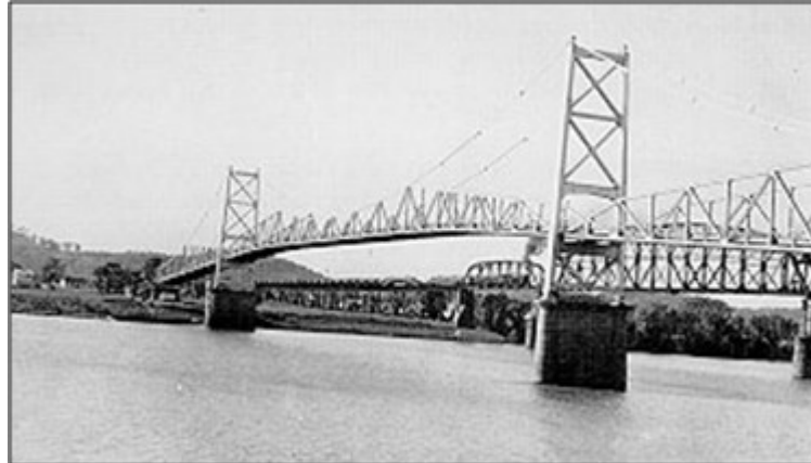
Figura 1 Point Pleasant Bridge prima del crollo [6]
