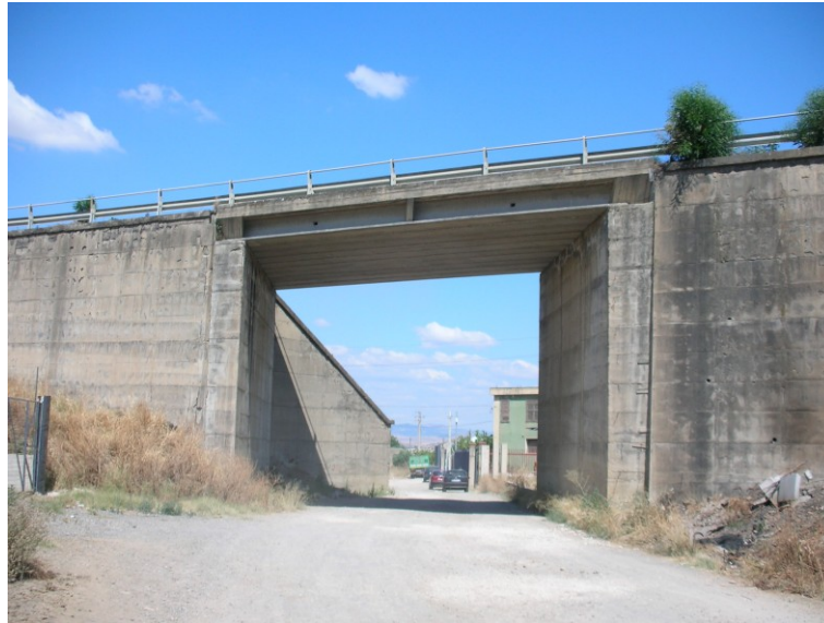
Figura 22 Ponte al km 30+619
