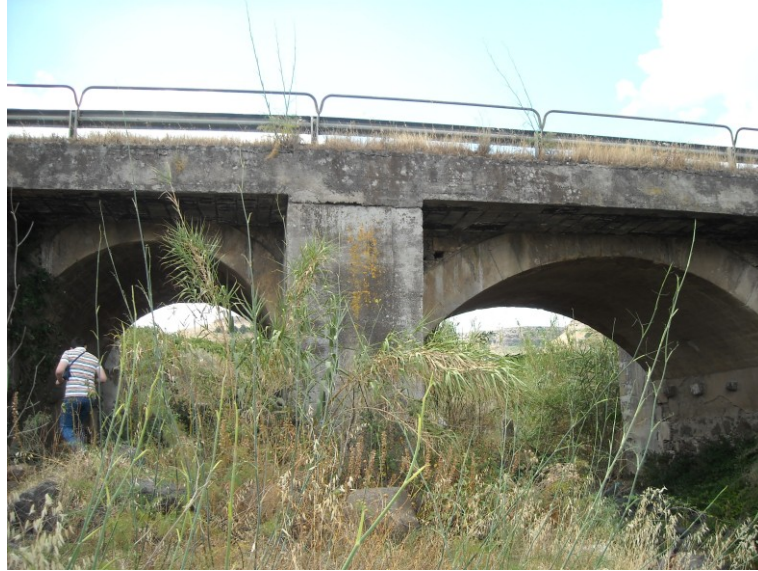
Figura 9 Ponte al km 24+685
