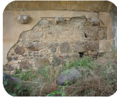
Figura 34 Muratura ammalorata
