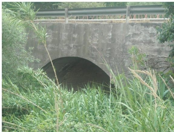
Figura 30 Ponte al km 42+554
