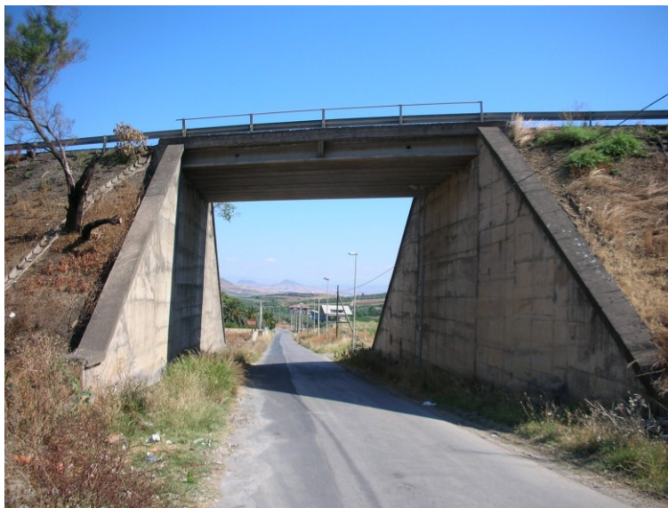
Figura 18 Ponte al km 29+922
