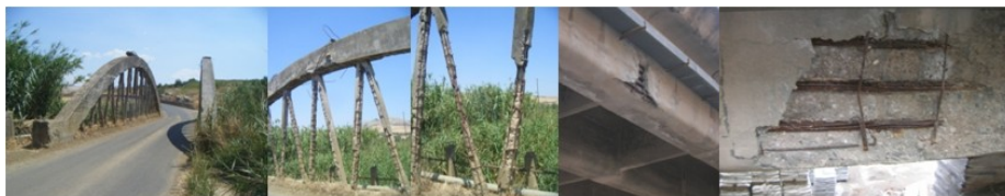
Figura 7 Ponte sulla SP 182
