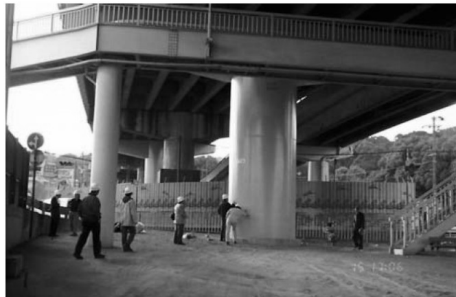
Figura 26 Esempio di incamiciatura in acciaio [26]
