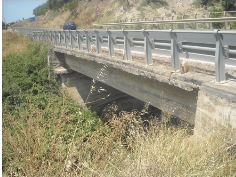
Figura 28 Ponte al km 39+916
