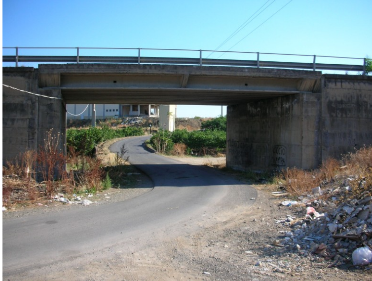
Figura 14 Ponte al km 29+070
