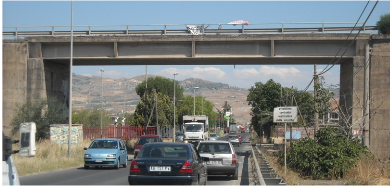
Figura 20 Ponte al km 30+506
