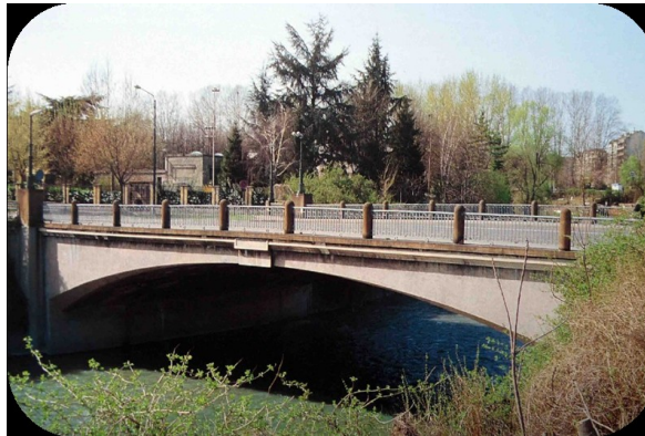
Figura16 Ponte Carlo Emanuele III, Torino [13]
