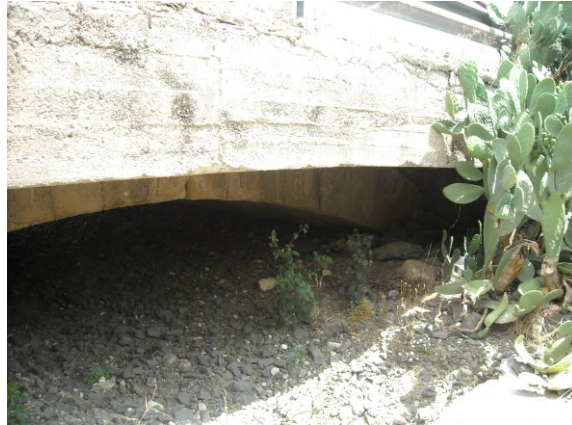
Figura 12 Ponte al km 26+249
