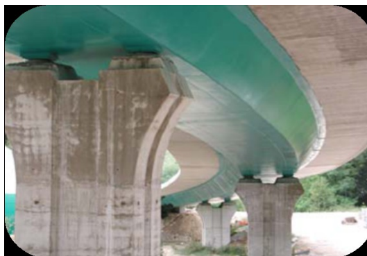
Figura19 Viadotto Fontescodella, Macerata [15]
