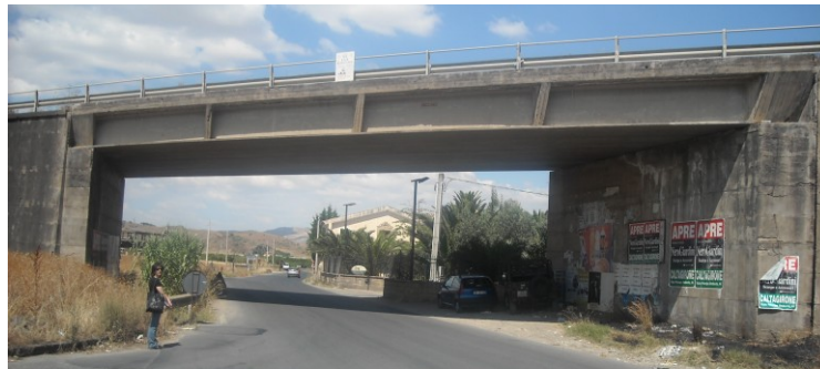
Figura 24 Ponte al km 30+729
