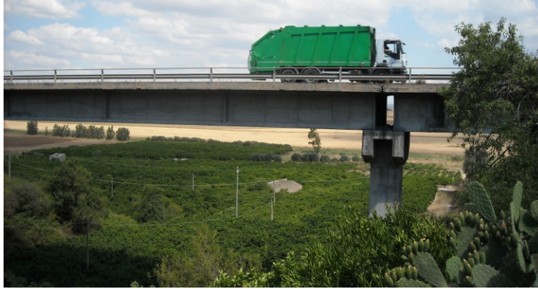
Figura 5 Ponte al km 2+149
