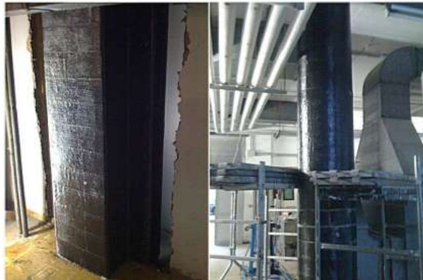
Fig. 1.68 Rinforzo di strutture in cemento armato
