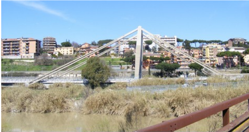
Figura 1.1: Ponte con tiranti in conglomerato cementizio armato.
