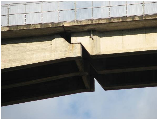
Figura 1.2: Travi da ponte in calcestruzzo armato.
