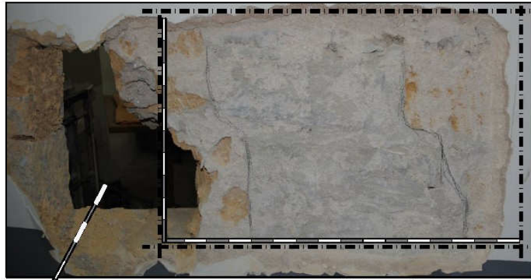
Nota: malta scarsamente coesa con giunti erosi
