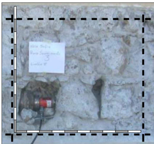
Ingranamento nel piano del paramento L.M.T=1,43 - P.R.
