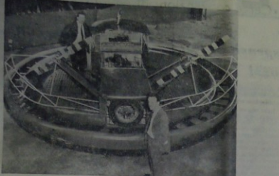
Un nuovo tipo di «Cushioncraft» cioè «veicolo che si muove su un cuscino d'aria» a stero elastico in Gran Bretagna. Il veicolo ruota soltanto di qualche centimetro dal suolo d'aria compressa e si muove per mezzo di due eliche.
