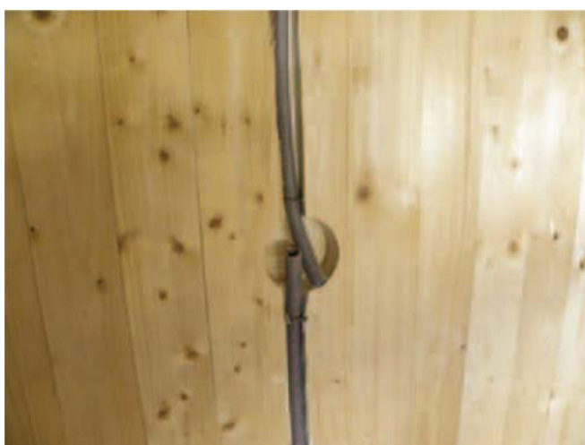
Figura 7.45– Posa in opera di tubo flessibile corrugato da 25 mm. (24)
