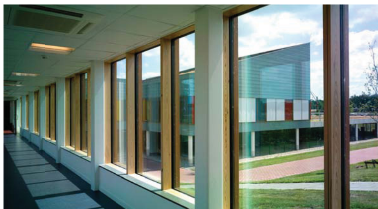
Figura 5.2.7 – Finestre basse in legno.
