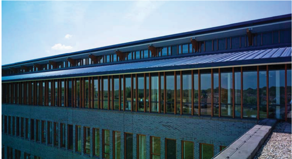
Figura 5.2.3 – Prospetto con materiali lapidei sul versante nord 2 .
