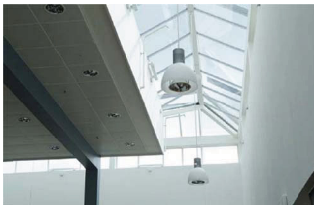
Figura 5.3.10 – Copertura parzialmente vetrata in uno dei cortili interni dell'ospedale.
