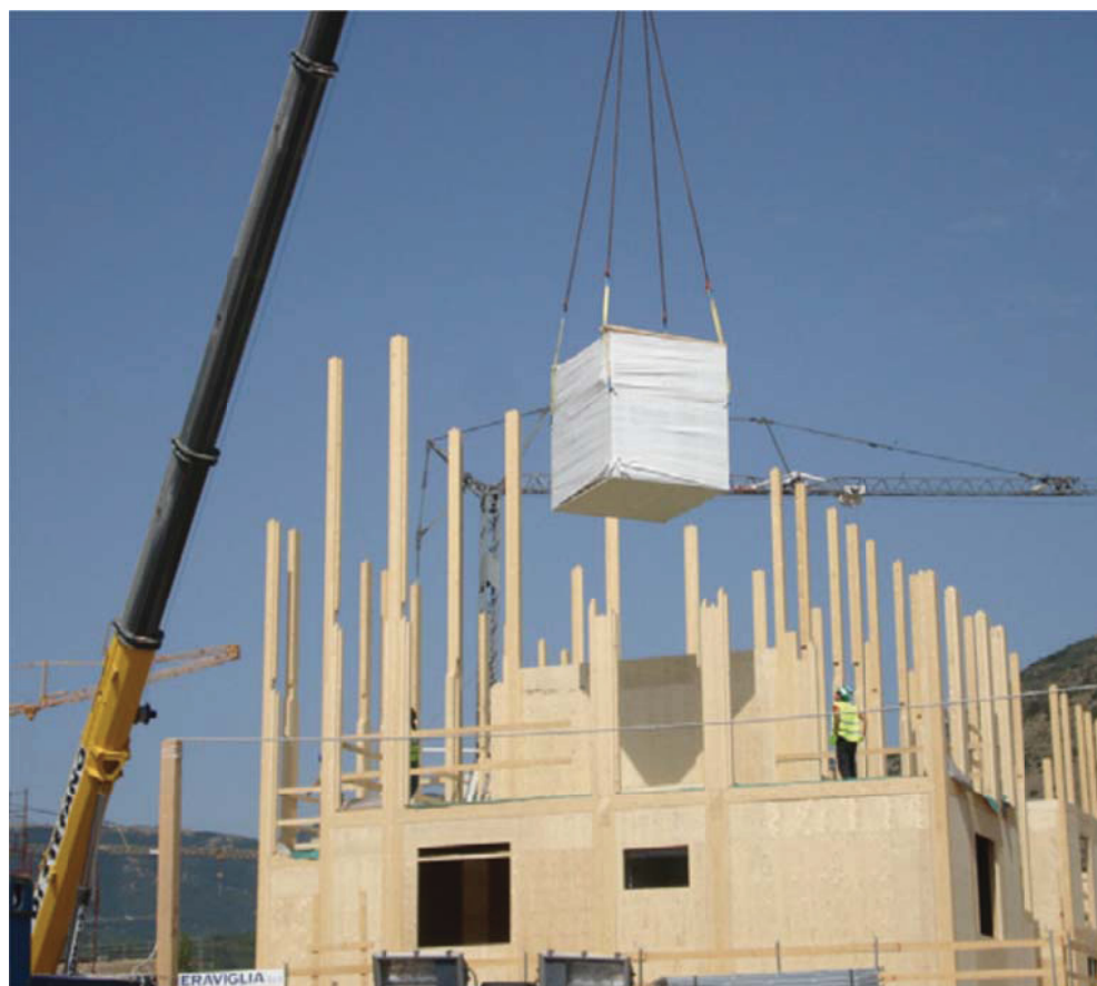
Figura 7.43 Posa di una cellula spaziale bagno della Modulbagno in una abitazione del progetto C.A.S.E. in Abruzzo
