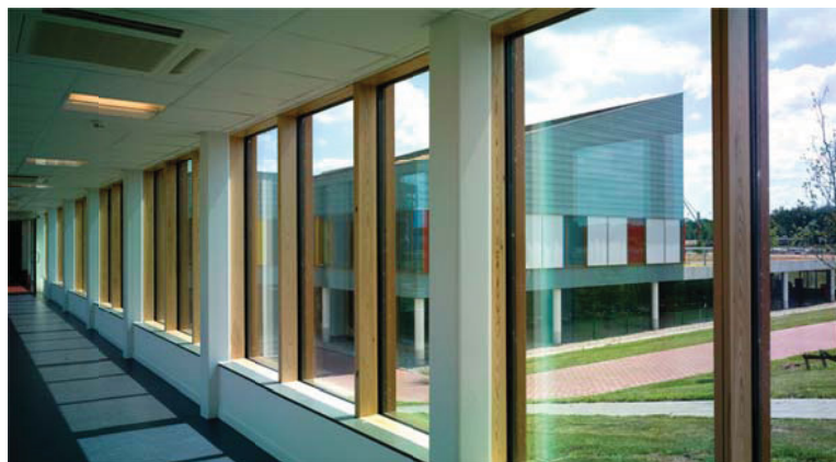
Figura 5.2.11 – Finestre basse in legno.
