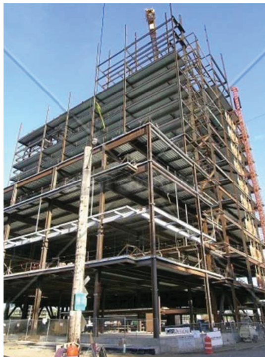
Figura 6.2.12 – Foto del cantiere – prospetto nord
