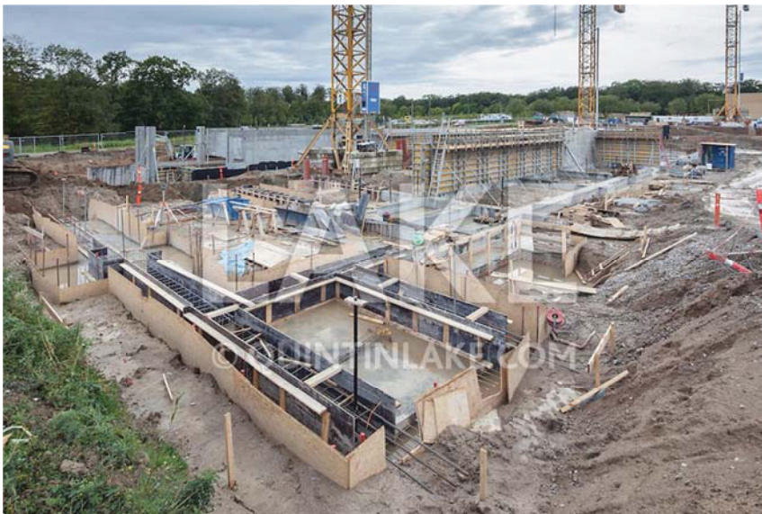
Figura 5.3.8 – Foto del cantiere, settembre 2012 1 .
