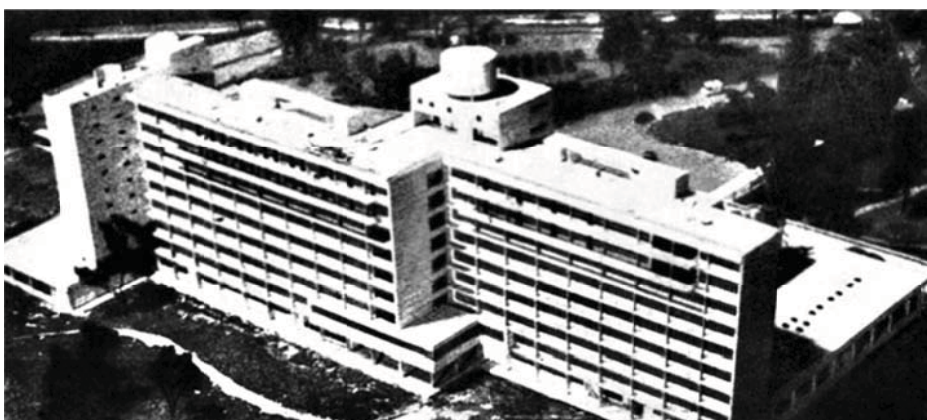
Figura 1.23. Ospedale di St.lo, Francia -vista aerea.
