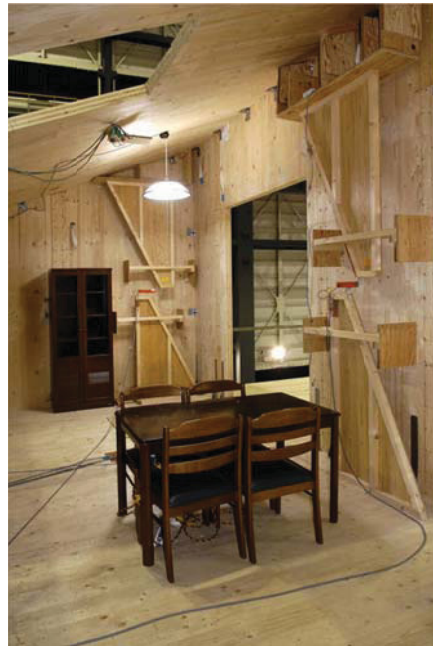
Figura 7.7 – Prova sismica effettuata su un edificio di sette piani costruito con pannelli X-LAM, Miki in Giappone, vista interna.
