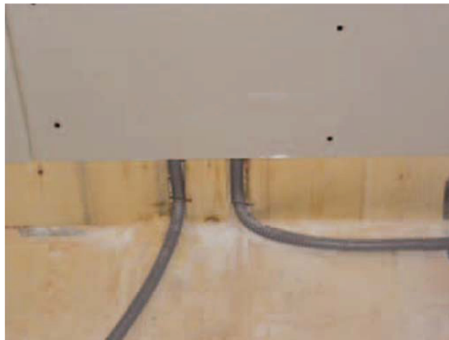
Figura 7.47 – Posa tubazioni a pavimento. (24)
