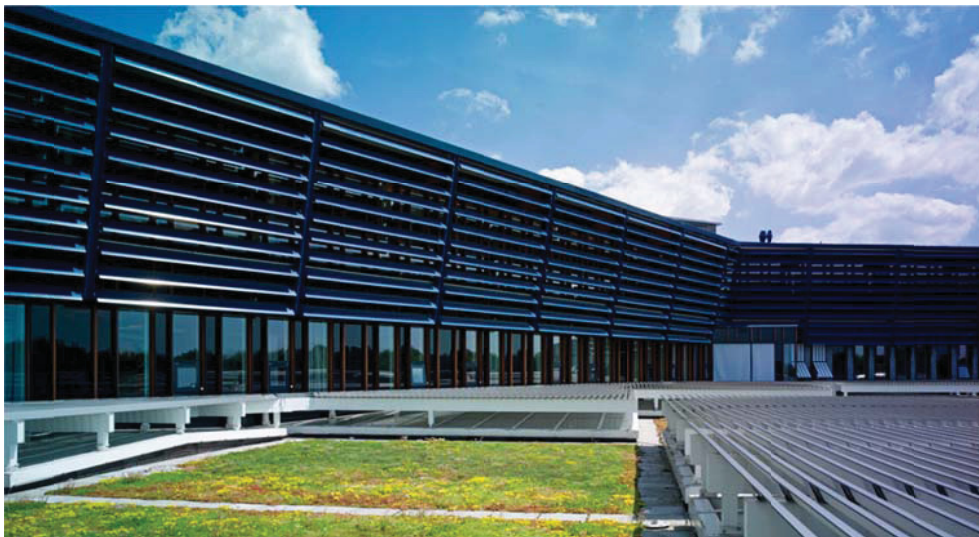
Figura 5.2.4 – Facciata vetrata sul versante sud 2 .
