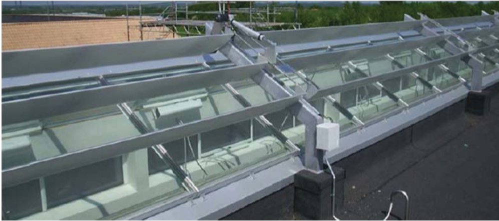
Figura 5.3.11 – Dispositivi di schermatura in copertura.
