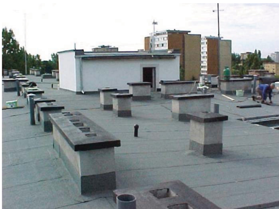
Figura 5.5.5 – Ristrutturazione della copertura (prima e dopo).
