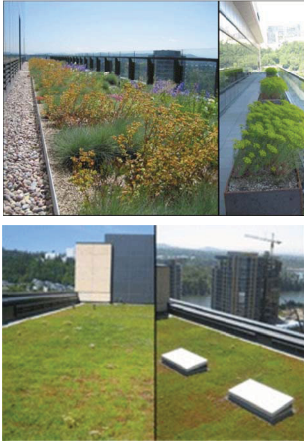
Figura 6.2.10 – Giardini pensili al sedicesimo e quindicesimo piano (foto a sinistra) e in copertura (foto a destra).
