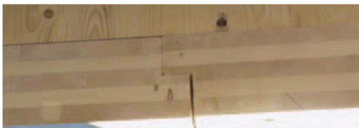
Figura 8.23 - Vista dall'alto del collegamento fra 2 pannelli delle chiusure verticali.
