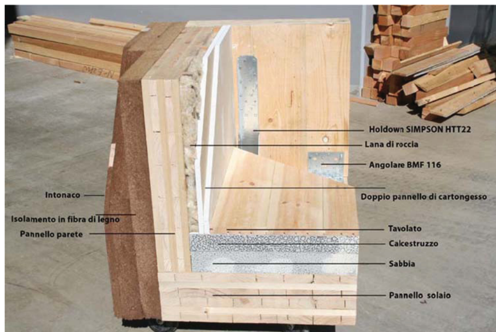
Figura 7.29 – Stratigrafia di una COB.
