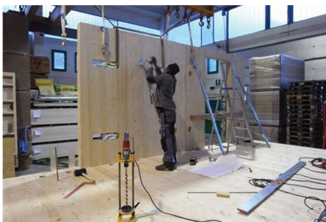
Figura 7.9– Lavorazione in stabilimento e montaggio in cantiere di una parete X-LAM.
