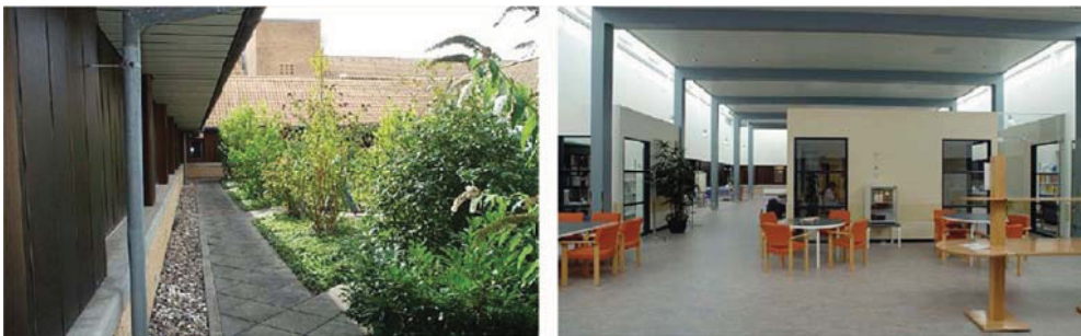
Figura 5.3.13 – Cortile prima e dopo la realizzazione della copertura parzialmente vetrata.
