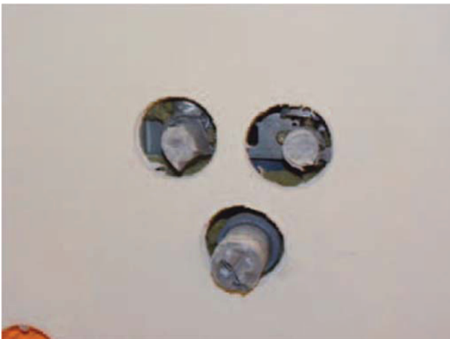
Figura 7.48 – Attacchi acqua e scarico. (24)
