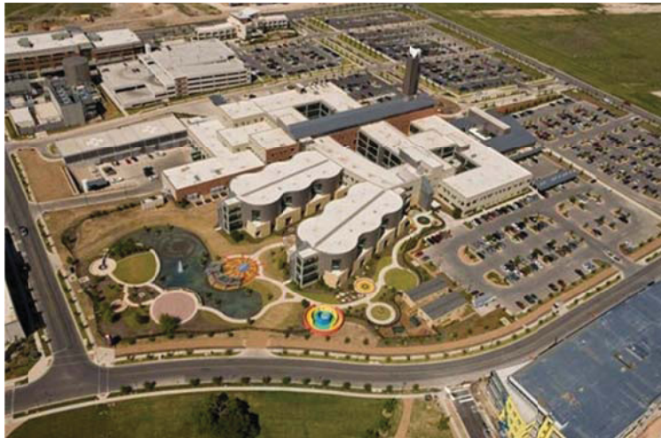
Figura 6.1.2 – Dell Children's Hospital, prospetto e vista aerea.
