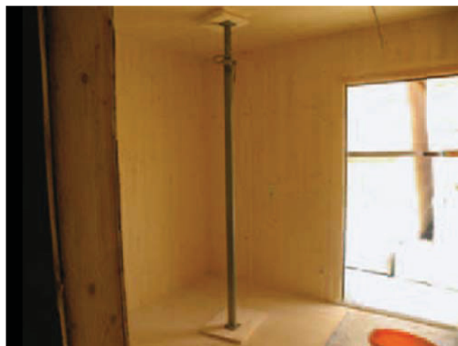
Figura 7.10 – Puntello di montaggio e puntello per solaio.
