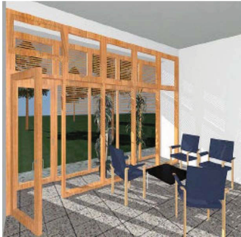
Figura 5.4.9 – Facciata a doppia pelle vista dall'interno.
