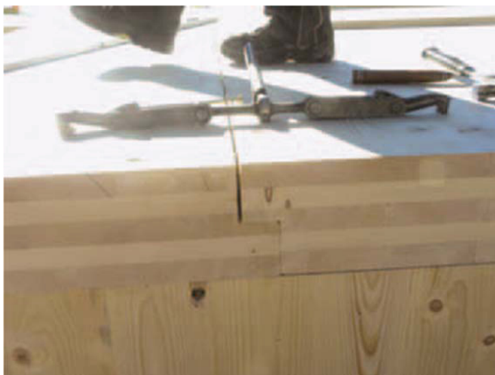
Figura 8.28 - Particolare dell'accostamento di più pannelli solaio-solaio.
