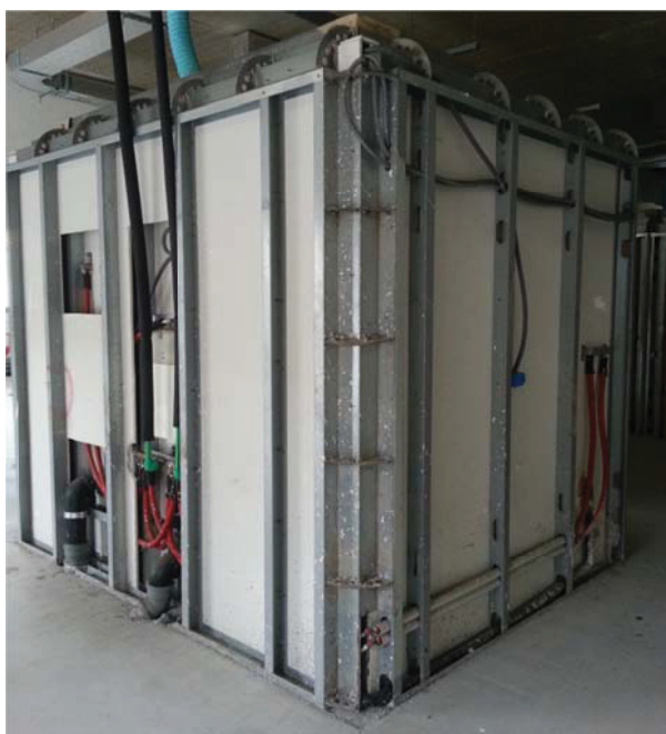
Figura 7.42 Vista esterna di una cellula spaziale bagno prodotta dalla Modulbagno
