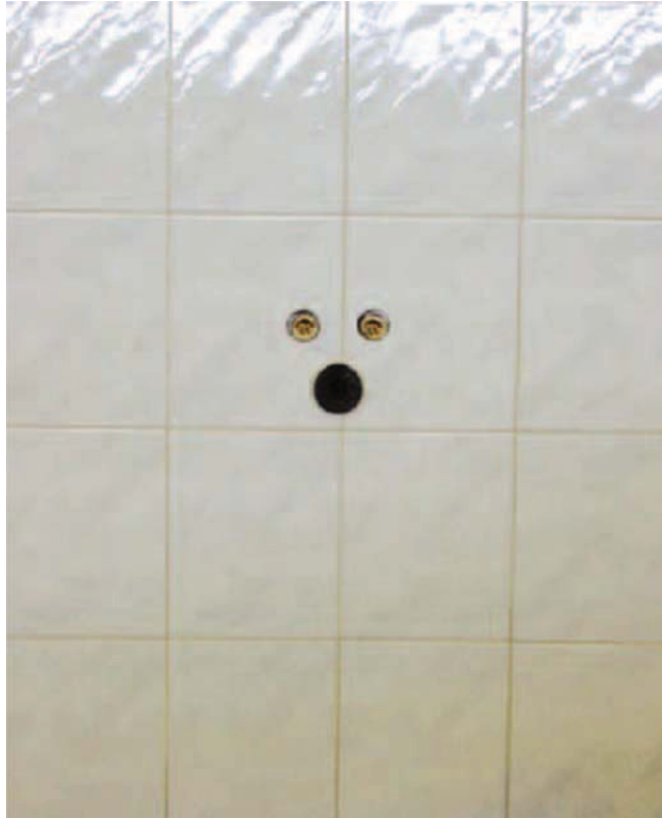
Figura 7.49 – Posa in opera di piastrelle su lastra in cartongesso ignifugo. (24)
