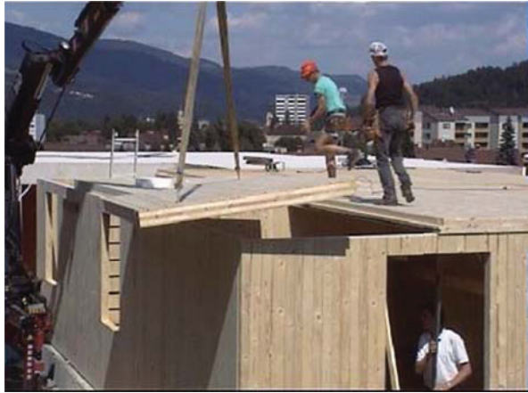
Figura 7.34 – Montaggio di pannello in legno X-LAM per copertura piana.
