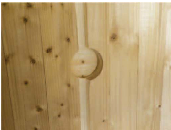
Figura 7.44– Fresatura delle scanalature per tubazioni. 25
