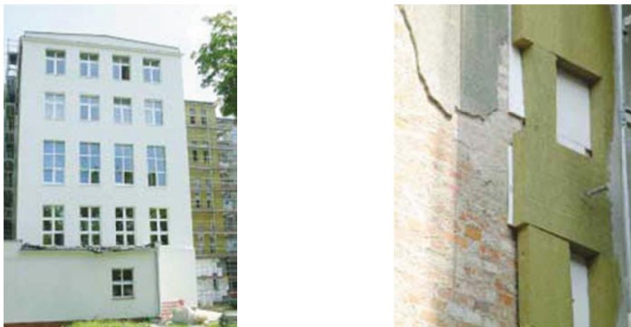
Figura 5.5.3 – Inserimento di un unico strato di isolamento termico in facciata.
