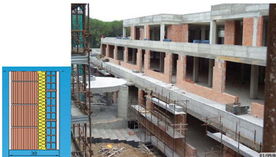
Figura 5.1.19 – Pareti esterne a cassetta con materiale isolante.
