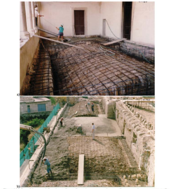
Figura 16 - Consolidamento delle volte mediante allargamento e getto in opera di una cappa in c.a. armata alle strutture murarie. a) in corrispondenza dei piani intermedi e b) in corrispondenza del sottotetto
