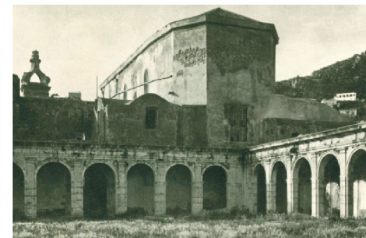
Parete absidale e copertura della Chiesa prima del restauro del 1927
