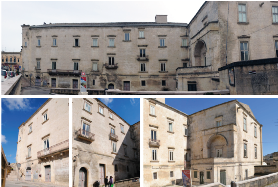
Figura 4.4 - Vista generale e foto di dettaglio del fronte ovest su via Casalnuovo
