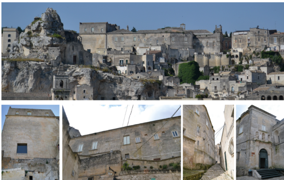
Figura 4.6 -Vista generale e foto di dettaglio del fronte est su via di via San Francesco. In basso a destra è inquadrato l'ingresso secondario al museo, sul fronte retrostante su piazzetta Belvedere.
