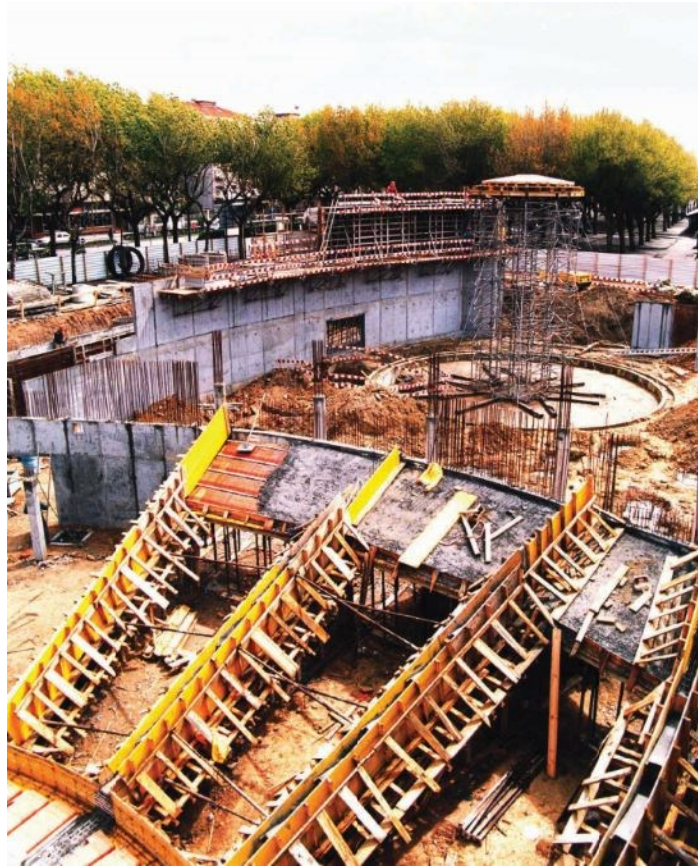
Prima fase del montaggio
