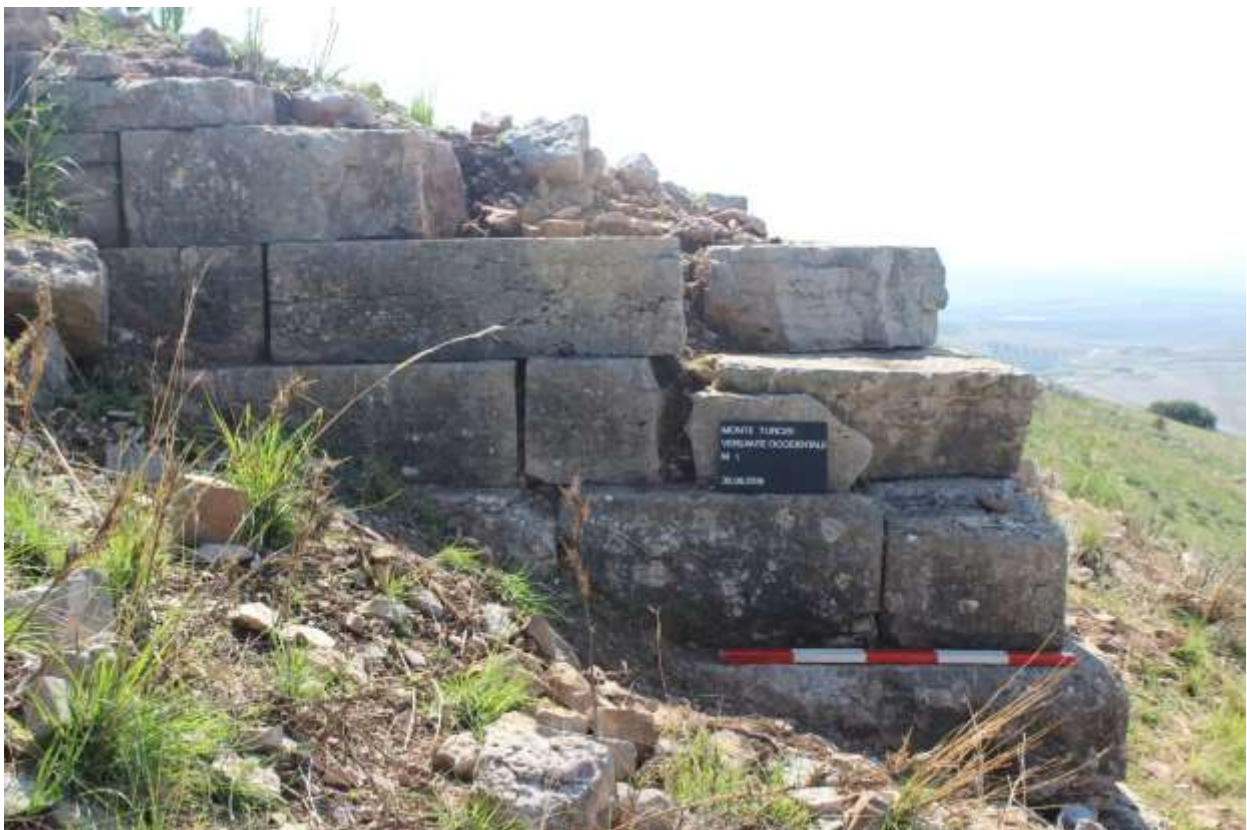
Fig. 52b. Castel di Iudica, Monte Turcisi, fortificazione del versante occidentale (da JONASCH, WINTERSTEIN 2016).
