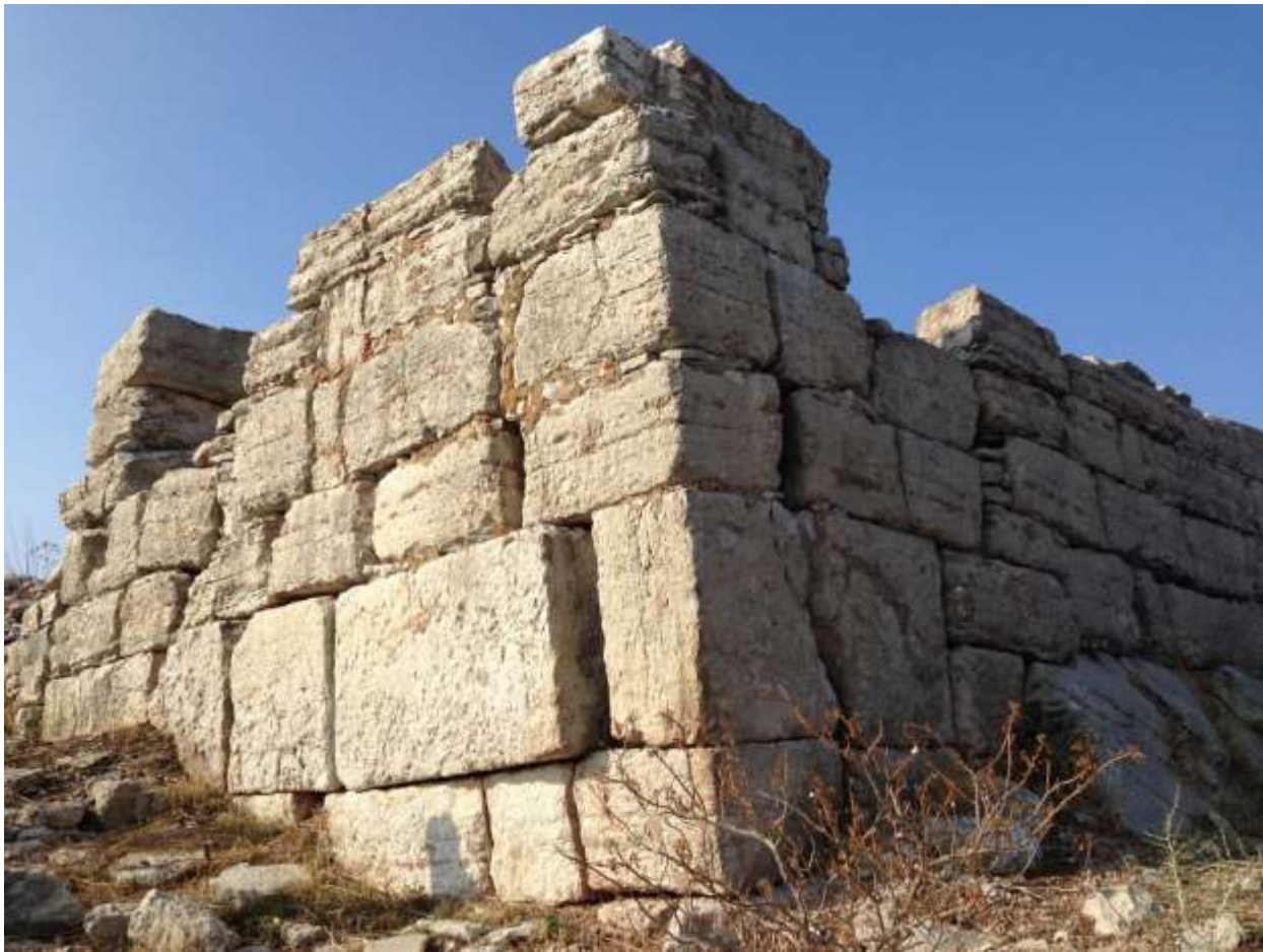
Fig. 17. Margini occidentali della Piana di Catania, Monte Turcisi: a) vista da Nord; b) porta Nord.
